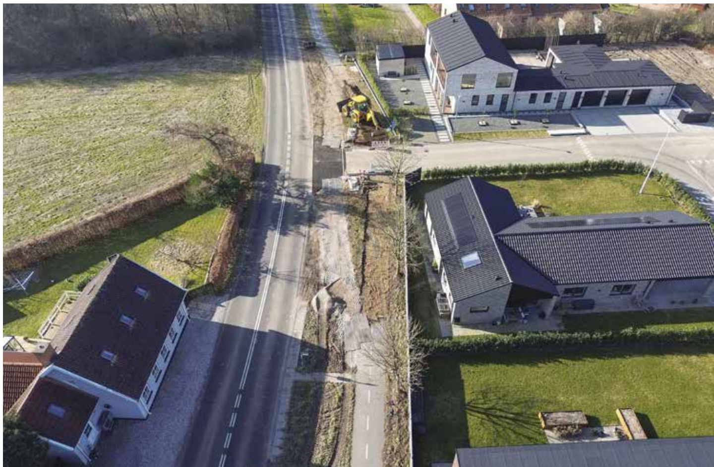
Den nye og den gamle cykelsti ses tydeligt på dette billede, som er taget 7. marts i år, mens arbejdet med at omlægge cykelstien stod på. Nu er afstanden til udkørslen fra Hørretvænget blevet længere. Foto: Ole Nielsen
