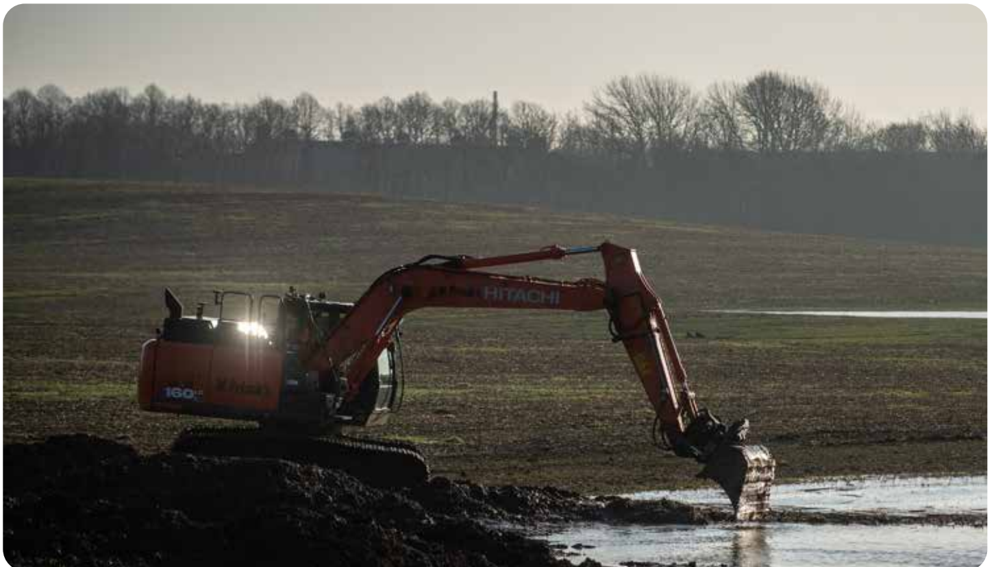
Gravning ved Vilhelmsborg Nord
