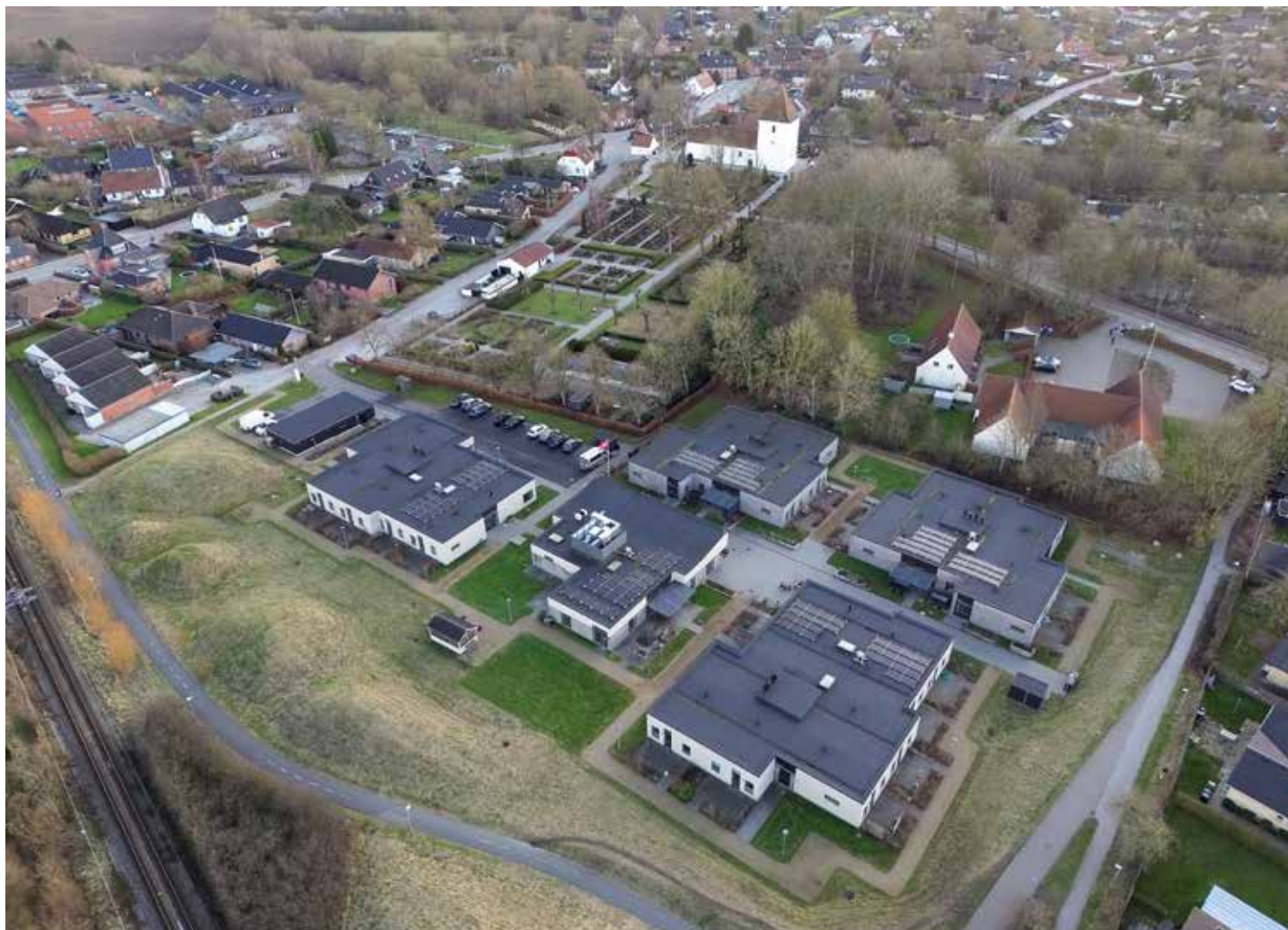
Bofællesskabet set fra oven. Der er fire selvstændige huse med i alt 28 tovcærelses lejligheder, hvoraf to er aflastningsboliger. Desuden er der et aktivitets- og fælleshus. I fælleshuset er der et produktionskøkken, hvor maden tilberedes. Foto: Ole Nielsen
