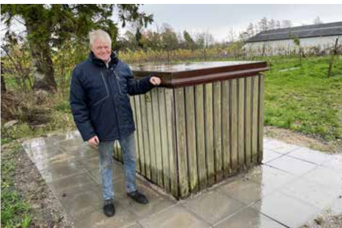
Transformatoren er allerede på grunden, og det er en kæmpe fordel, siger Poul Hakon Poulsen.
