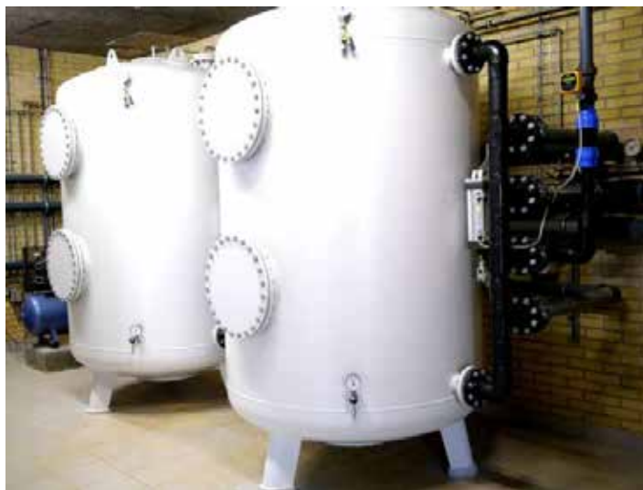
Et eksempel på vandværkets nye inventar - her to af værkets trykfiltre
