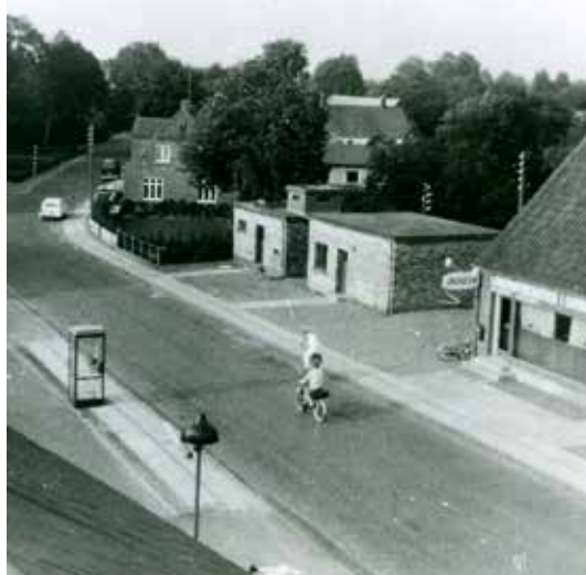
Mårslet Vandværk på adressen Tandervej 1. Billedet er taget efter 1947
