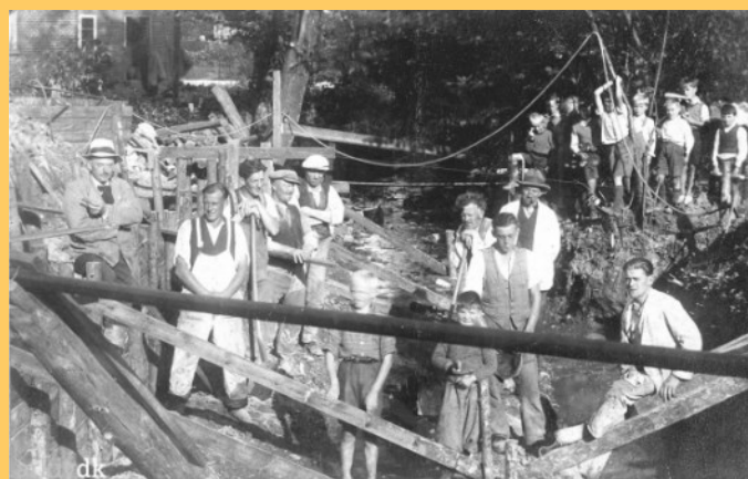
1935. En ny bro over Tandervej blev bygget som et beskæftigelsesprojekt af Mårslet Kommune. Brobyggeriet var håndarbejde uden anvendelse af maskiner.
