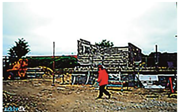
Halhuset under opførelse i 2000. Halhuset blev indviet 20. januar 2001.
