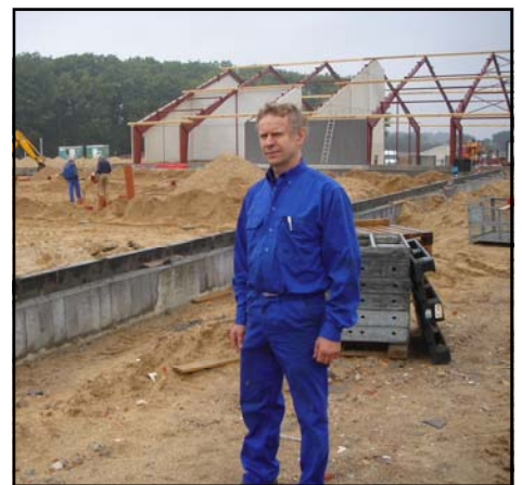
Bent Munk Nielsen følger spændt byggeriet ved Tandergård.
