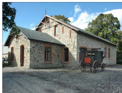
Herskabsstalden, der nu er smukt restaureret
