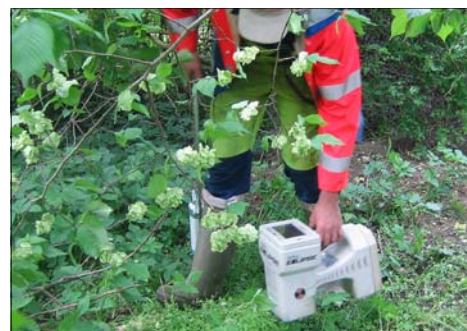
Teknikeren kan på sonden - med centimeters nøjagtighed - aflæse og styre boret's bevægelser dybt nede i jorden.
