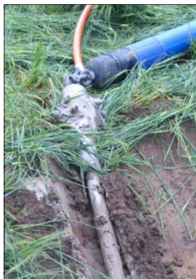
Før boret trækkes tilbage, monteres vandrøret på borehovedet.
