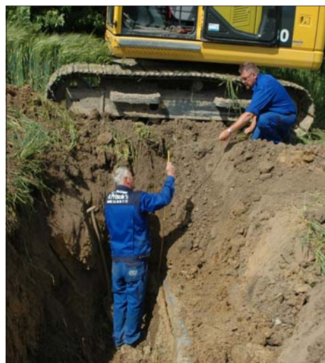
Den gode gamle gravko er langt fra kasseret. Over halvdelen af strækningen er gravet på denne måde.
