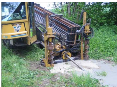
Maskinen skyder røret gennem jorden i 3½ meters dybde.
