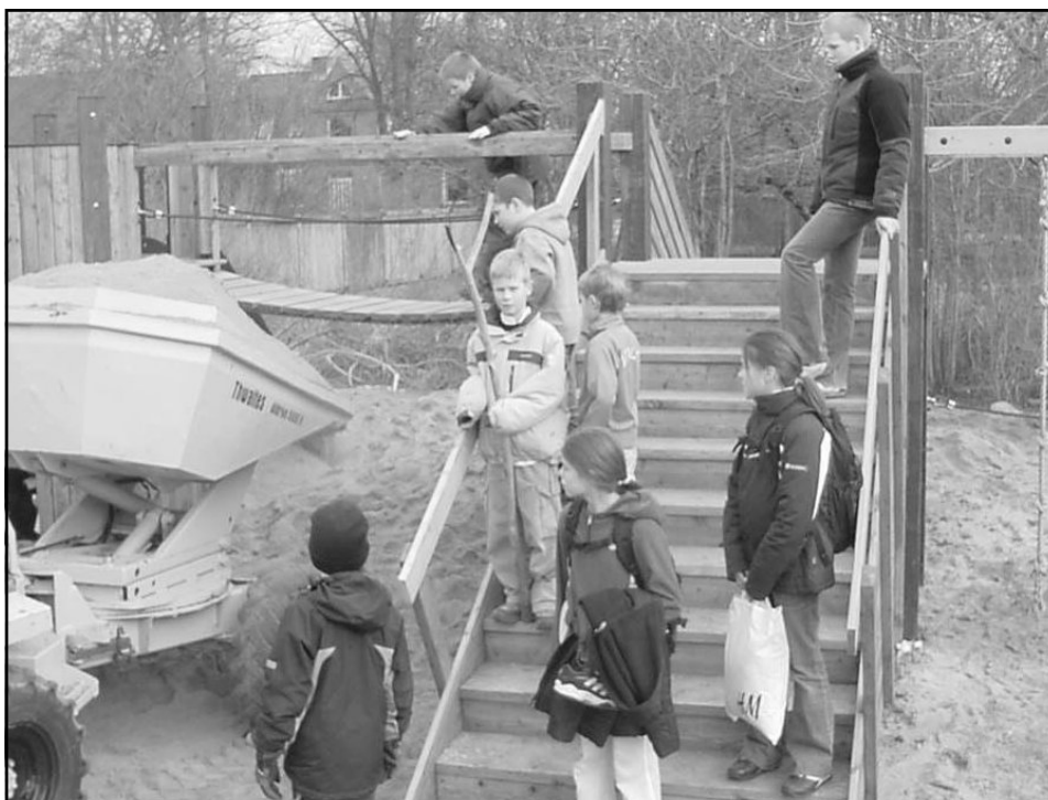
Legeborgen foran A-huset under konstruktion.
